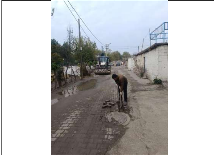
Dicle Mahallesi Su Tahliyesi Onarım Çalışması
