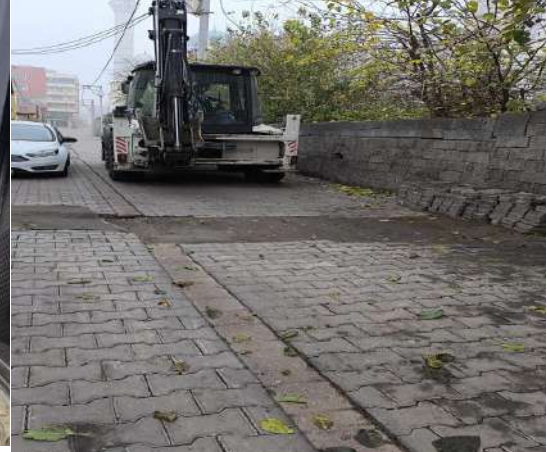
Fırat Mahallesi Kilitli Taş Onarımı Çalışması
