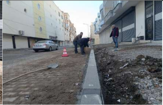
Akpınar Mahallesi Dicle Caddesi Kaldırım Bordürü Çalışması
