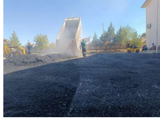
Alibey İlkokulu zemin düzeltme ve asfalt çalışması
