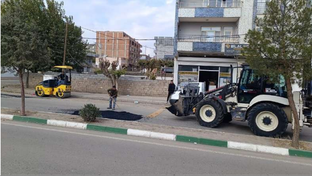
Nato Caddesi Asfalt Çalışması
