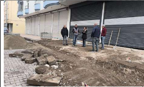
Akpınar Mahallesi Dicle Caddesi Kaldırım Çalışması
