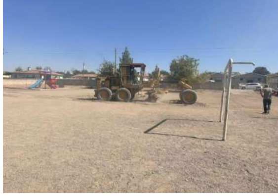
Alibey İlkokulu zemin düzeltme ve asfalt çalışması
