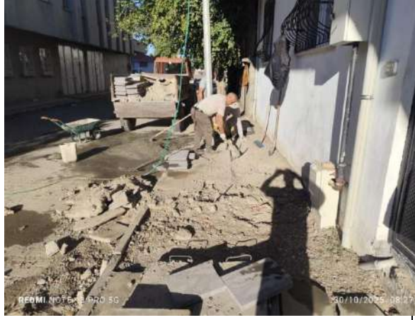
Fırat Mahallesi Kaldırım Onarımı Çalışması
