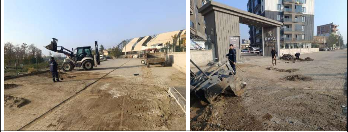
Sanayi Mahallesi Kilitli Taş Onarımı
